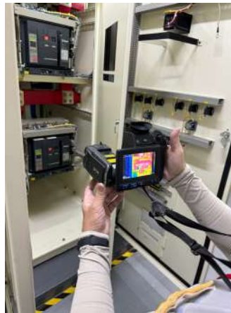
高壓電氣設備檢測
